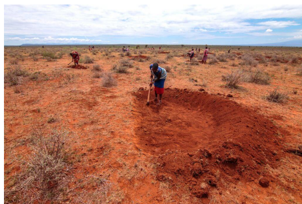
Construindo Bunds em Kenia, Africa
