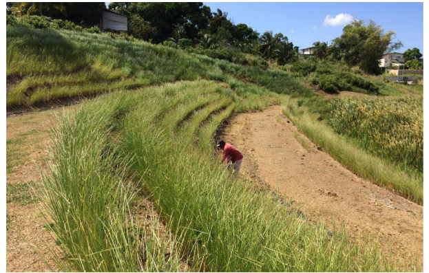
Barreira com Capim Vetiver
