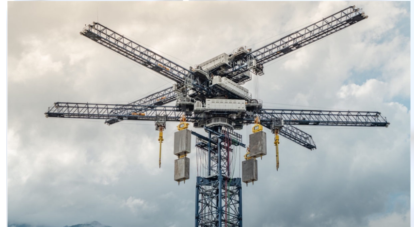
Bateria por Gravidade
