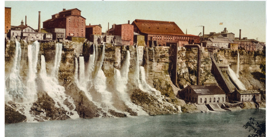
Love Canal - Indústria em EUA contaminando o rio .
