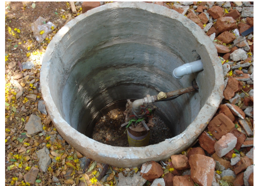
Recarregando um poço
