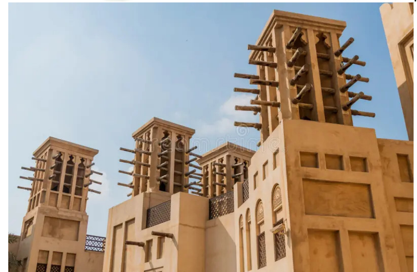
Torres de Ventilação Tradicional. Trombe.
