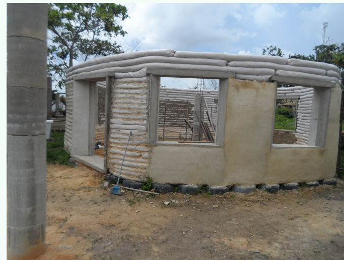
Paredes quase Prontas
