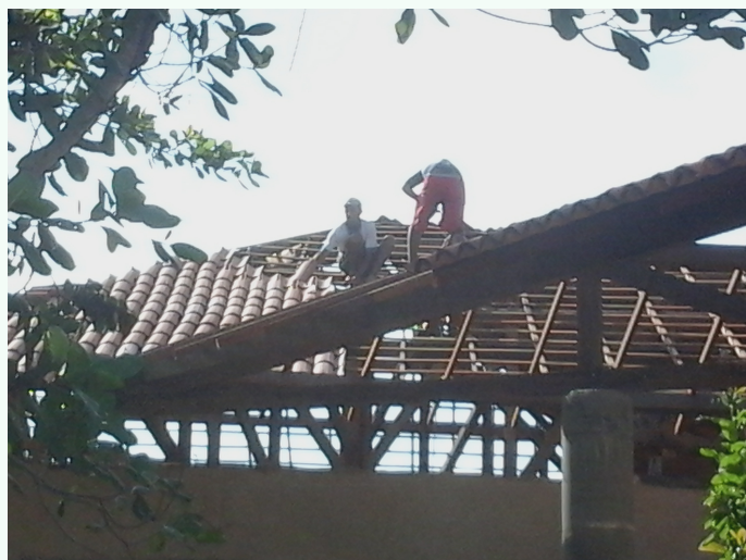
Colocação das Telhas
