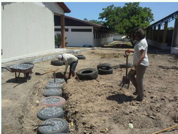
Base da fundação - Pneus Reciclados e Brita
