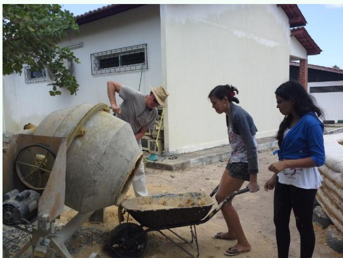
Fazendo a Massa para Reboco
