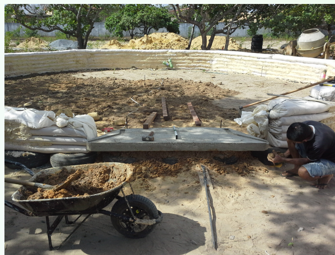
Colocando a Base da Porta
