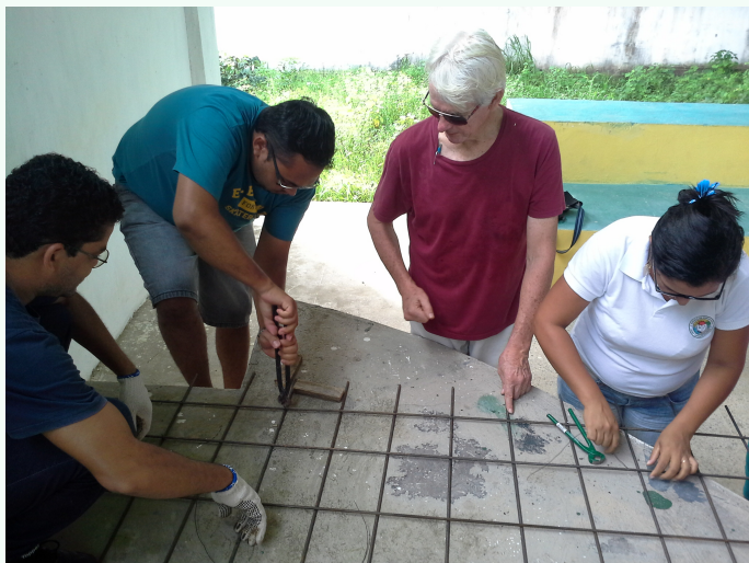
Amarração para Cisterna para Água
