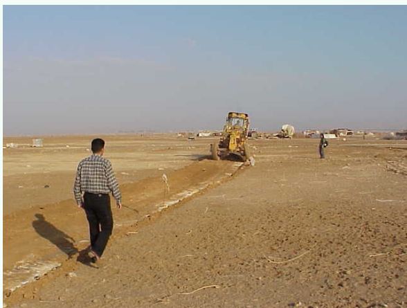
Construindo Swales em Jordão - área árida
