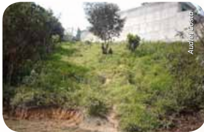
Situação anterior à recuperação
